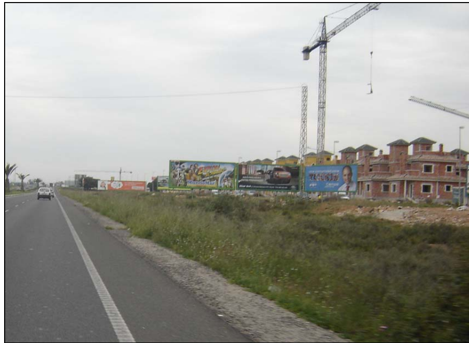
Ilustración 8. Residencia Lo Marabú. Vista del residencial Lo Marabú en sentido sur-norte.
