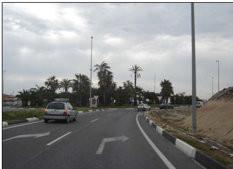
Ilustración 5. Aproximación a la rotonda de acceso a Benijófar.
