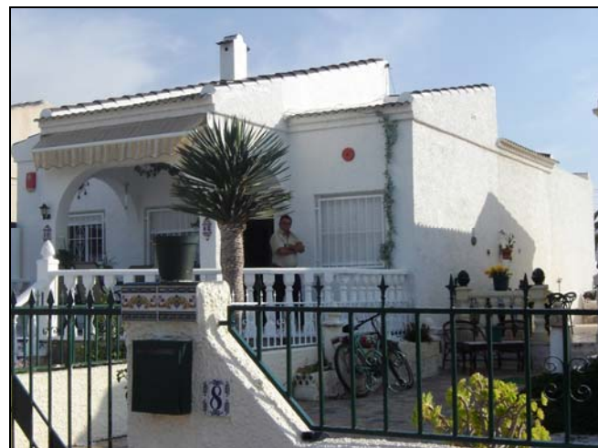
Ilustración 103. Edificación Unifamiliar de PB en la urbanización de San Luis.
