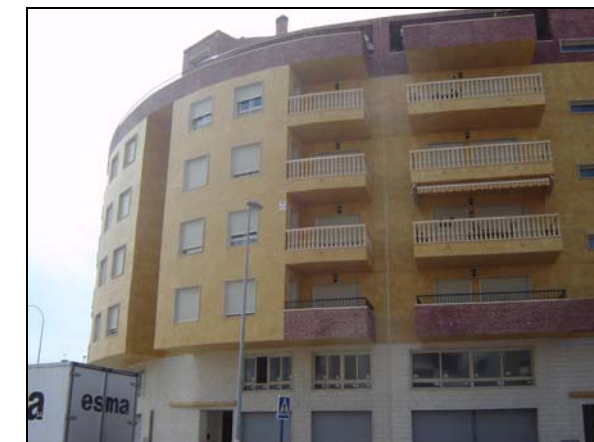
Ilustración 90. Bloque de viviendas situado en primera línea al final del tramo de estudio de la carretera CV-930.
