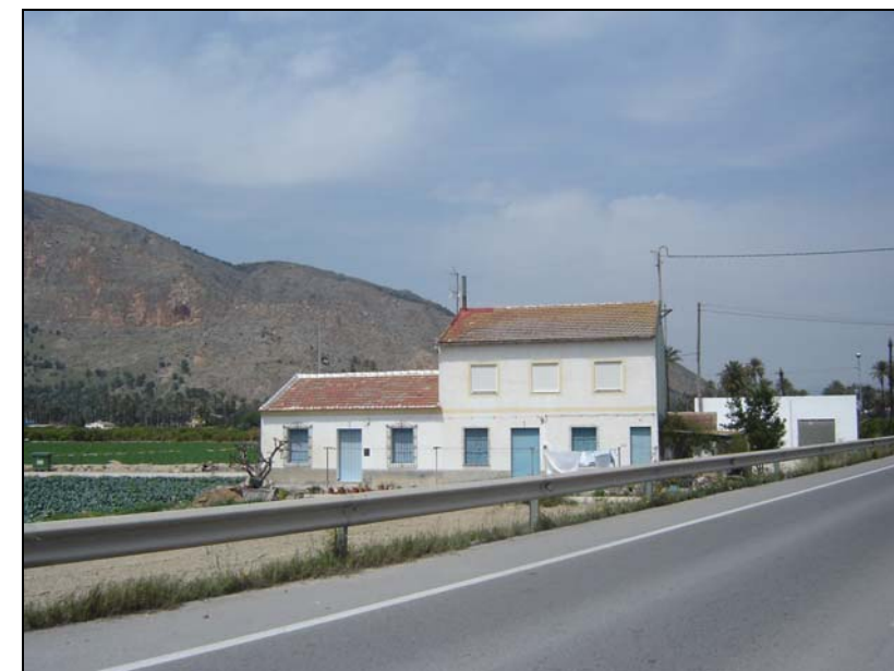
Ilustración 29. Vista de la carretera.
