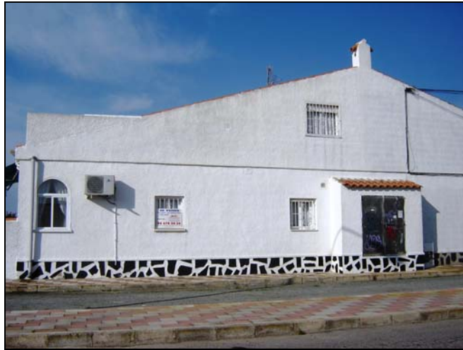
Ilustración 102. Edificación Unifamiliar de PB+1 en la urbanización de San Luis.
