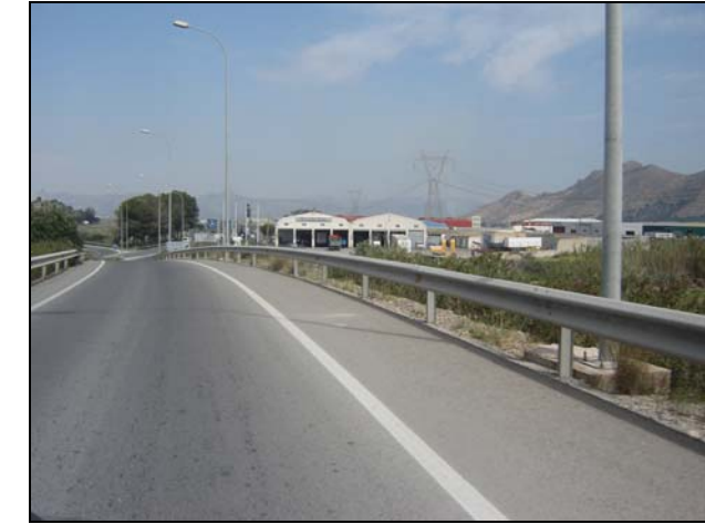
Ilustración 21. . Vista del inicio de la CV-905 en el enlace con la N-340 .
