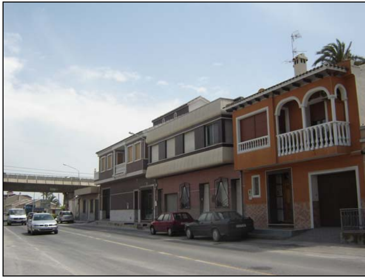
Ilustración 23. Carretera CV-930 sobre la carretera CV-900.
