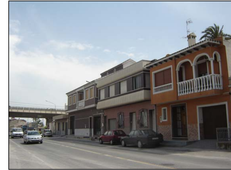
Ilustración 83. Intersección de la carretera CV-930 (paso elevado) con la carretera CV-900
