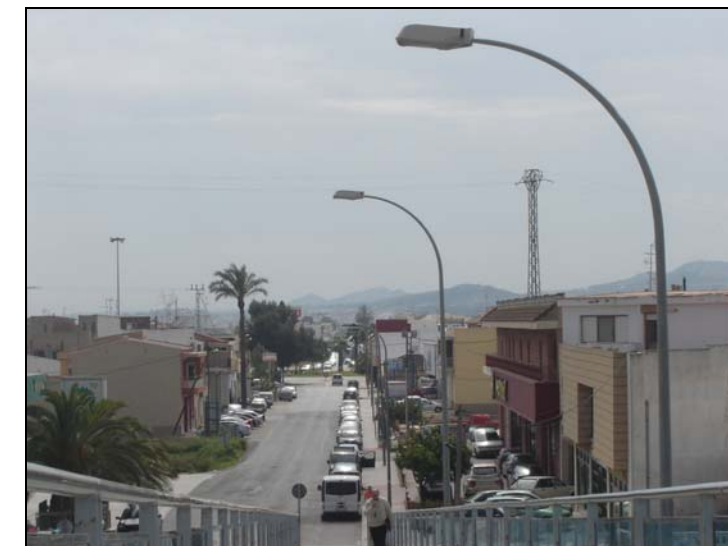
Fotografía 14. Paso peatonal superior
