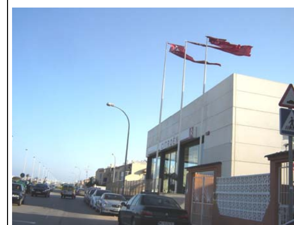
Ilustración 113. Detalle de edificio Comercial
