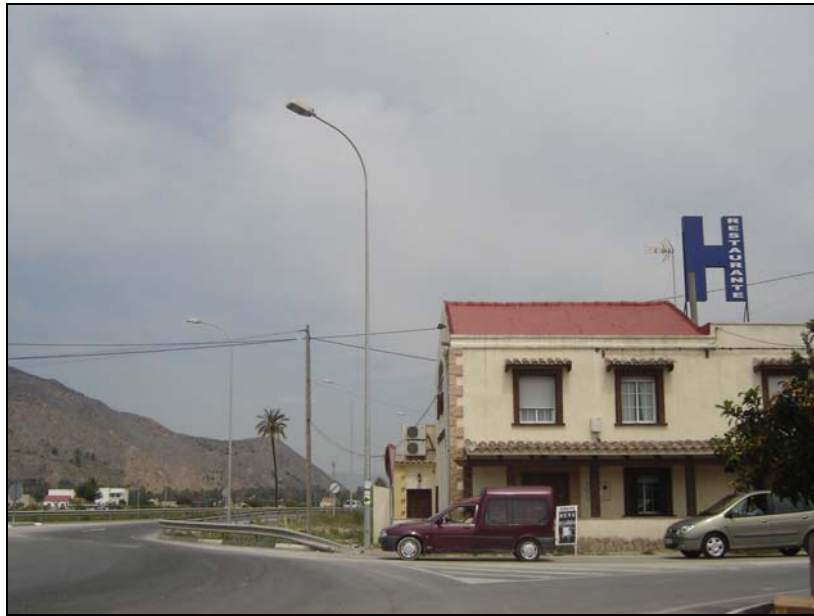
Ilustración 33. . Rotonda de intersección entre las carreteras CV-930 y CV-91
