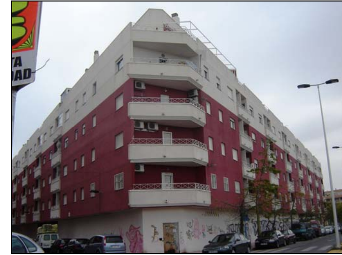
Ilustración 63. Bloque residencial de cinco plantas al final del tramo de estudio.
