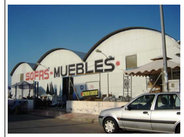
Ilustración 114. Detalle de edificio Comercial
